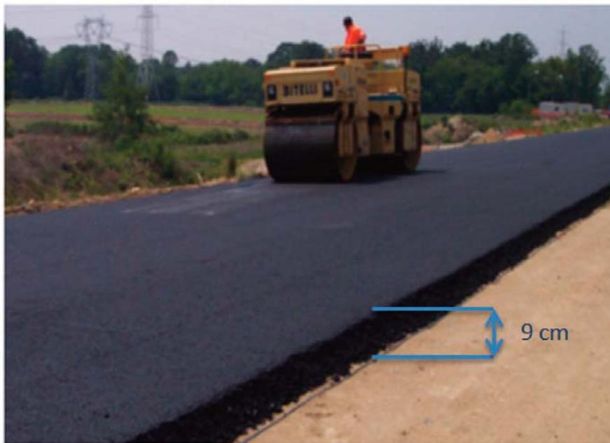
*Figura 2 Colocación en obra del nuevo subbalasto bituminoso.*
