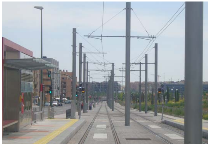
Figura 3. Postes en el centro de la vía doble en línea de metro ligero
