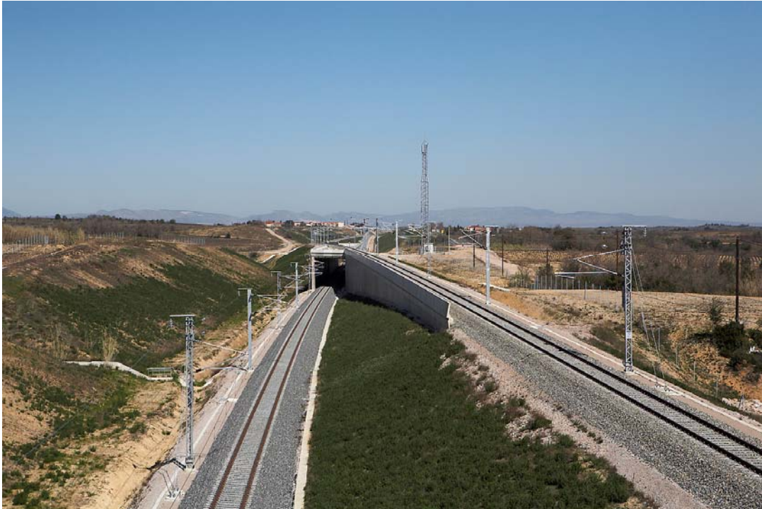
Figura 5. Salto de carnero en la línea de alta velocidad de Figueres a Perpignan para pasar de la circulación por la derecha en España a la circulación por la izquierda en Francia
